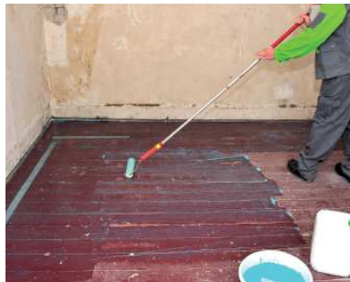
2 Penetrácia s KÖSTER VAP I 06 alebo pomocou KÖSTER SL Primer.
