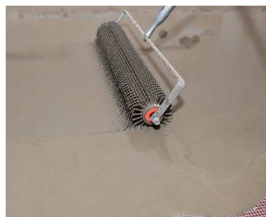
6 Nakoniec hmotu odvzdušníme valčekom - ježkom.
