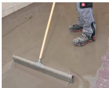
5 Podlahová nivelačná hmota sa nanáša na väčších plochách špeciálnym náradím.
