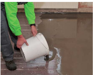
4 Nanesenie nivelačnej hmoty v požadovanej hrúbke vrstvy (miešať najmenej 3 minúty).
