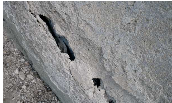
Opadávajúca omietka, alebo opadávajúce časti stavebných hmôt
