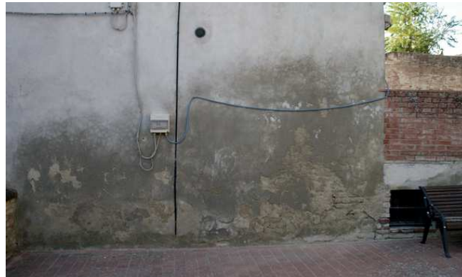
Zmena farby omietky, zníženie funkčnosti tepelnej izolácie
