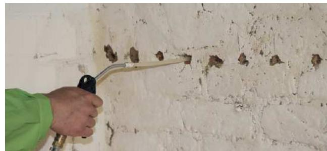
3 Čistenie vyvŕtaných otvorov pomocou tlaku vzduchu.
