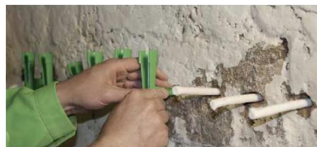
5 Vyčnievajúca kapilárna tyčinka Capillary Rod sa vtačí do plastového rohovníka.
