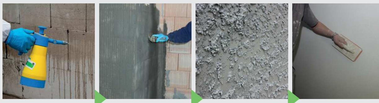
Stará omietka sa odstráni. Väčšie výtroky a diery sa vypravia výrobkom KÖSTER Repair Mortar. Potom sa na povrch nastriecka KÖSTER Polysil TG 500, aby sa zabránilo výkvetom solí a aby sa spevnil podklad.
